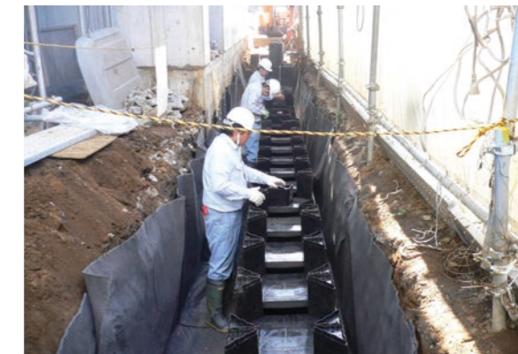
マンション敷地内
