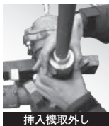
挿入機取外し
