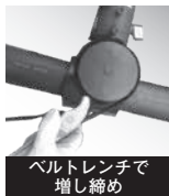
ねじが隠れるのを 目安に締め付ける
