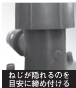
ベルトレンチで 増し締め
