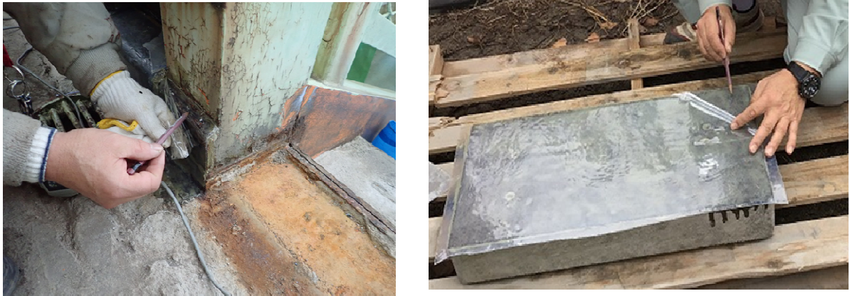
図 4.5.16 硬化確認状況(左が鋼構造物、右がCo 構造物)
