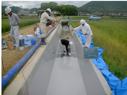
【例】 図 4. 5. 20 Co 構造物塗布状況
