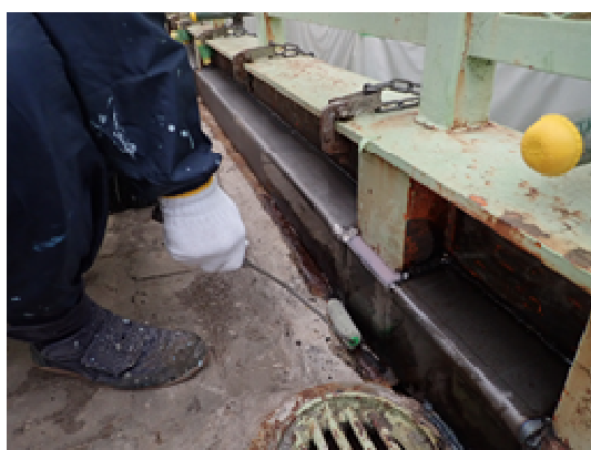
図 4.5.4 ベースプライマーの塗布状況(左が鋼構造物 右が Co 構造物)
