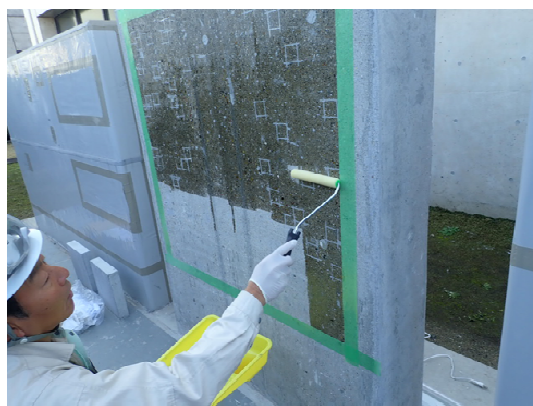
図 4.5.4 ベースプライマーの塗布状況(左が鋼構造物 右が Co 構造物)
