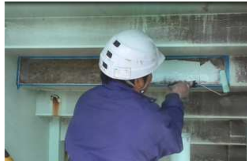
【例】 図 4. 5. 21 鋼構造物塗布状況
