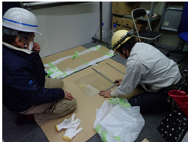
図 4.5.9 屋内でのシートカット状況
