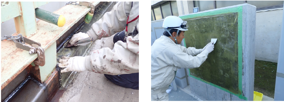
図 4.5.11 脱泡作業状況(左が鋼構造物 右がCo 構造物)
