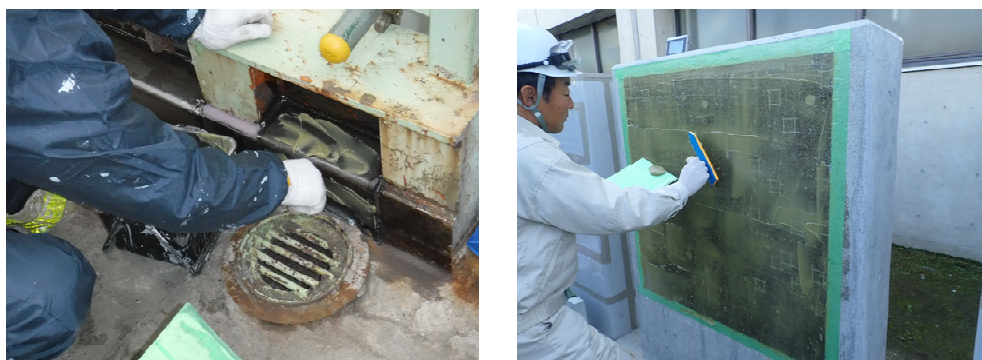
図 4.5.10 貼付プライマーの塗布状況(左が鉄 右がCo)
