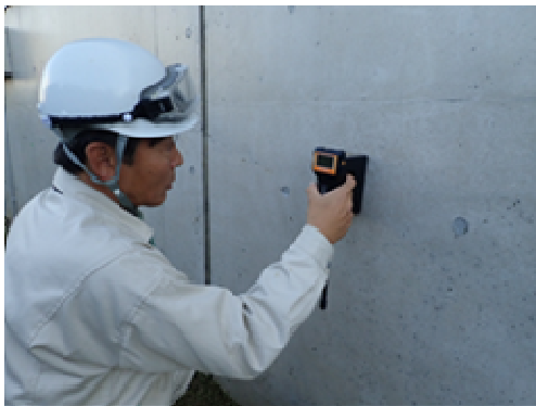
図 4.5.3 コンクリート水分量の計測状況
