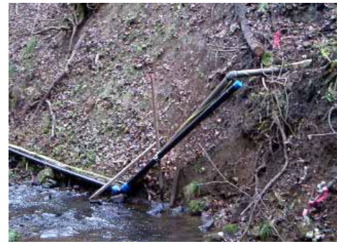
[ 事例 3 ] 破損管路の復旧 土砂崩れが発生した部分は、地盤が安定していな い為、斜面下に配管を布設していきます。
