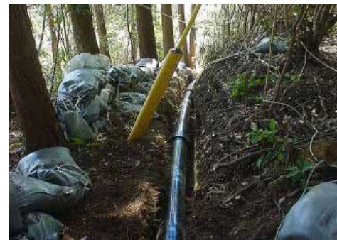
[ 事例1 ] 山間傾斜地での施工 外面保護層には、柔軟性の高い低密度ポリエチレン を採用。エスロンエコハイパー同様生曲げ施工により、構 造物を避けて、配管出来ます。
