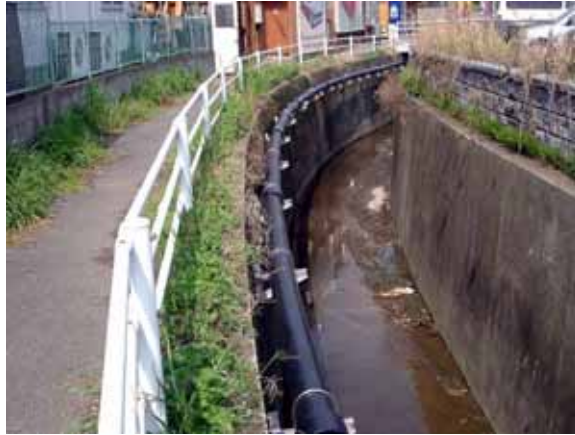
用水路の壁面に沿って、緩やかに曲げ配管を実施しました。 エスロンエコハイパーJW 150A, 曲げ半径 R = 40m
