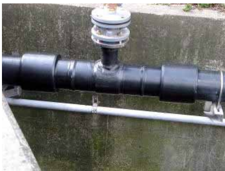
空気弁の設置には、保護層付のフランジ付 チーズを使用しました。
