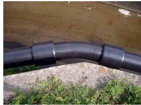
生曲げ施工が困難な曲部は、バンド管で対応。 直管と同様に保護層付きであり、現場で特殊な 施工は必要ありません。
