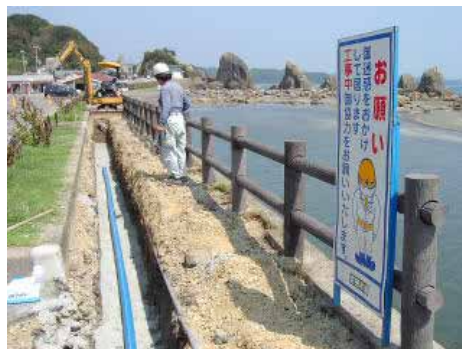
波打ち際に、沿うかたちで管を布設。今まさにエスロハイパー本州最南端記録を更新中。
