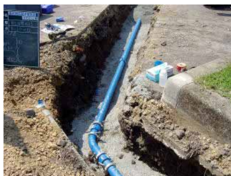
片受直管，片受ベンドの組み合わせ。切削・清掃が1口ですみ、便利です。
