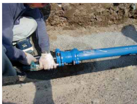
ボルトを締め付けて施工完了です。暑い中、お疲れ様でした。
