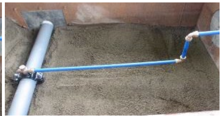
既設の金属製配水管から分岐する場合 耐震性を高めたサドル、金属継手の組合せ
