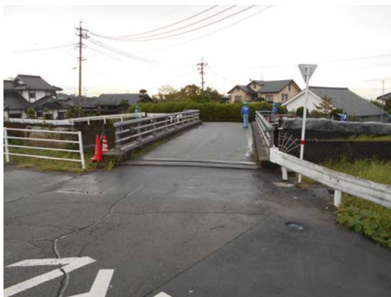
図1 益城町布設箇所(橋梁周辺)
