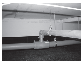
建物給水管の横引き管
