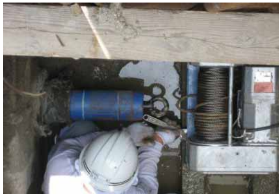
写真10 電動ウインチと到達した先導管
