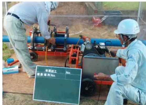
写真5 専用テント内での融着作業
