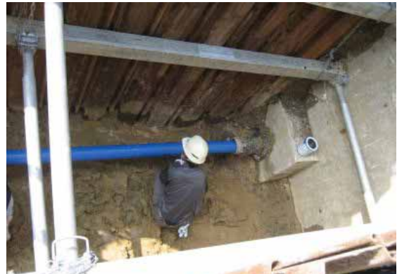
写真7 既設管への挿入
