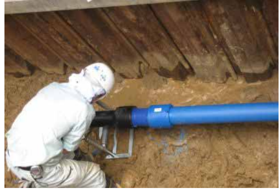
写真11 既設ダクタイル鋳鉄管との接続(異種管継手)
