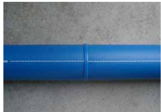
写真3 バット接合部
