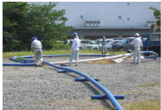
写真9 円形にして仮置きした長尺管
