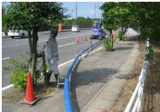
写真8 管引き込み開始時の状況
