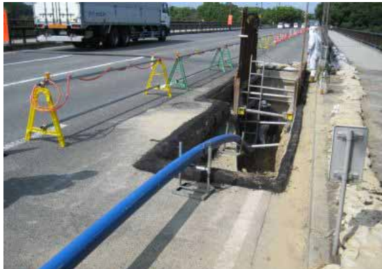
写真6 発進立坑から到達立坑をのぞむ
