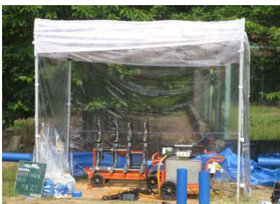
写真4 バット融着専用テント
