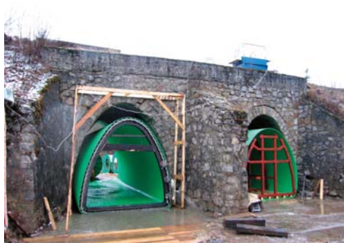
シベリア鉄道補強工事
