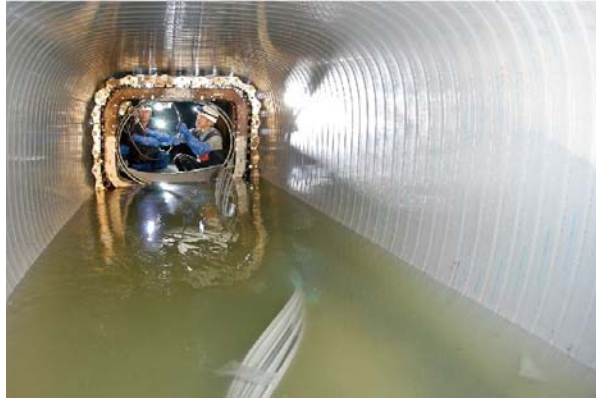
SPR工法施工風景
