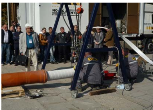
施工デモンストレーション
