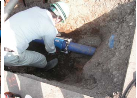
⑥圧着部補強 (EF継手)
