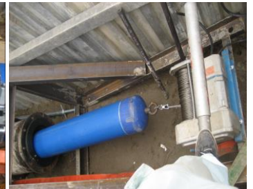
管の引き込み
