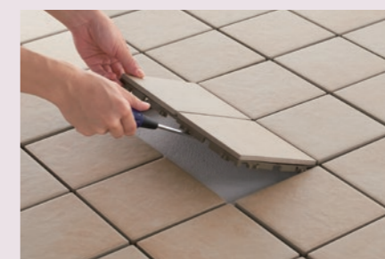
取り外すときは、目地にドライバーなどを差し込み、てこを使って持ち上げます。
