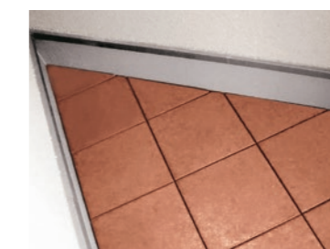
変形のバルコニーの端部
