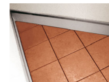
変形のバルコニーの端部
