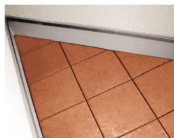
変形のバルコニーの端部
