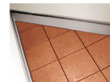
変形のバルコニーの端部
