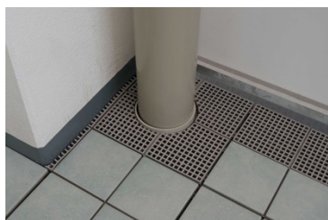
排水パイプのまわり
