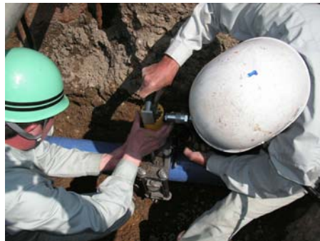
②工具の設置・圧着
