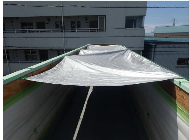
図4.5.8 遮光シートによる養生状況
