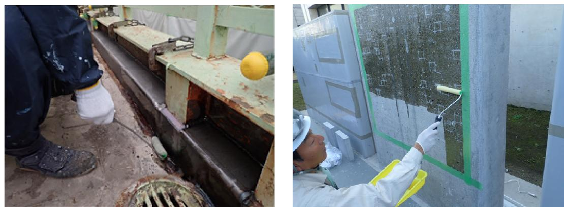
図 4.5.4 ベースプライマーの塗布状況(左が鋼構造物 右が Co 構造物)
