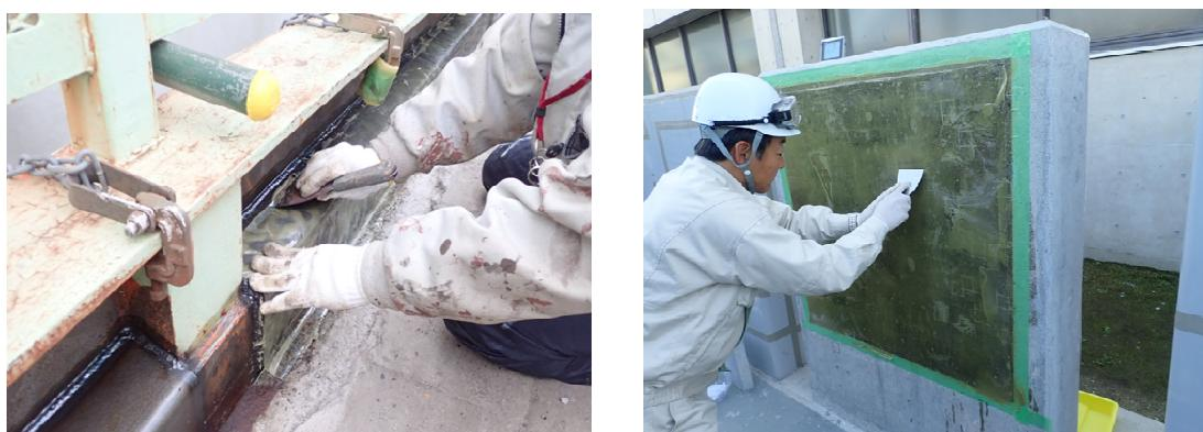
図4.5.11 脱泡作業状況(左が鋼構造物 右がCo構造物)
